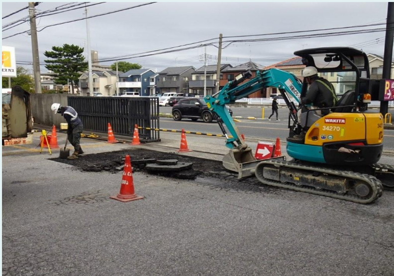
舗装工事の様子 📍
