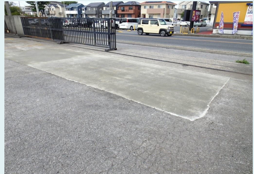
舗装工事完了後 📍
