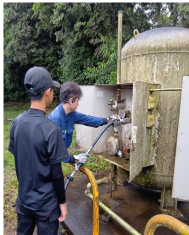
バルク貯槽へ充填中。
