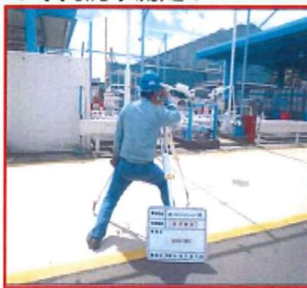
◆不同沈下とは、弱い地震の積み重ねにより、地盤が不揃いに沈下を起こすこと。この不同沈下により、プラットホームに傾きが生じていないか測定。
