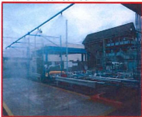
◆バルクローリー払出場、充填場プラットホーム、ローリー受入場の散水設備を作動させ検査。
