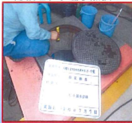
◆貯蔵タンクの隙間に詰められている砂に水分が多量に漏れ入っていないか目視点検。
