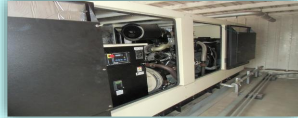
大型LPG発電機(8.8L V8ターボ) これ1台で事務所、充填所をカバー
