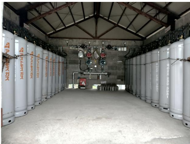
①訓練場所の簡易ガス特定製造所
