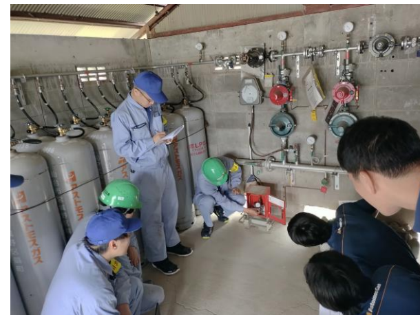
③その後、実際に遮断をして復帰操作訓練を行いました。
