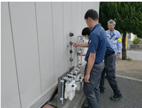
④帰社後は、セクターバルブの閉止訓練を行いました。
