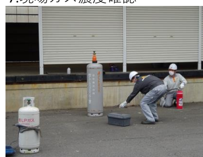
7.現場ガス濃度確認
