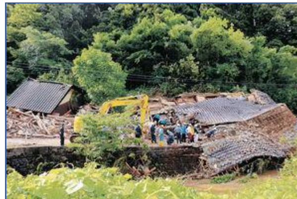
土砂崩れで倒壊した建物 (南砺市砂子谷)
