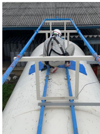
タンク上の散水配管塗装作業
