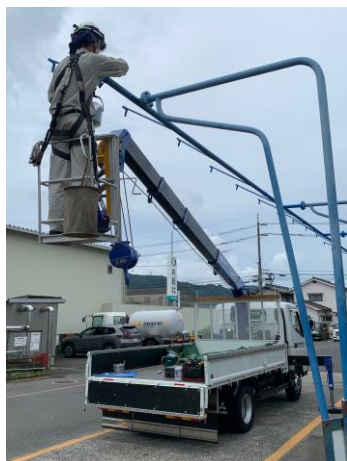
高所での散水配管塗装作業
