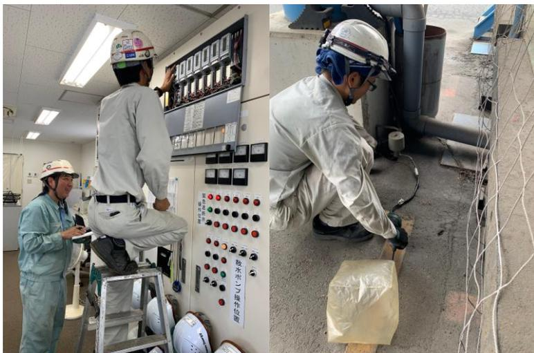
試験ガスを使ったガス検知警報装置の検査
